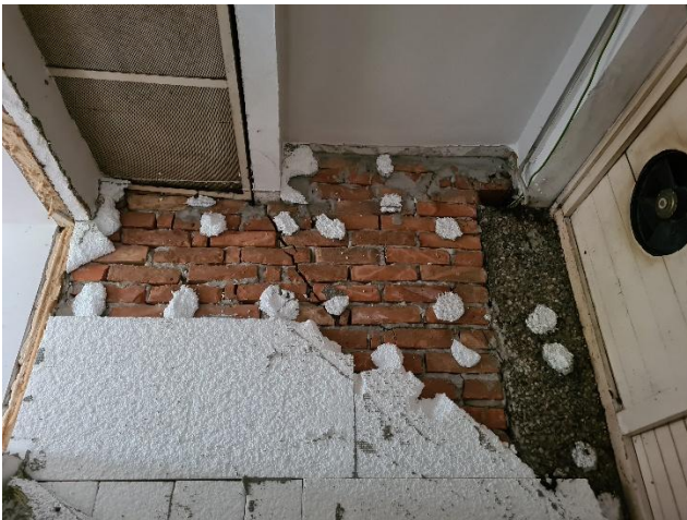
Slika 23. - Vertikalna pukotina - pregradni zid - spoj sa dijelom A
