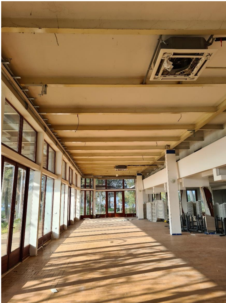
Slika 12 - dograđeni dio oznake B - nosiva čelična konstrukcija
