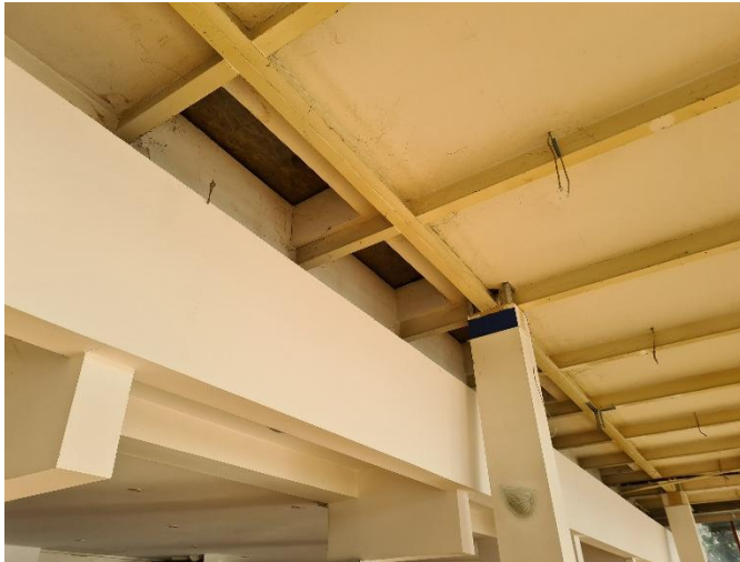
Slika 13 - dograđeni dio oznake B - nosiva čelična konstrukcija
