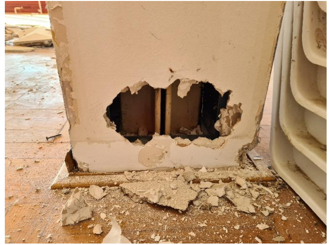
Slika 14 - dograđeni dio oznake B - nosiva čelična konstrukcija-stupovi
