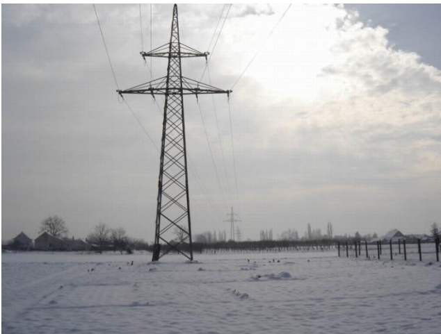
Prikaz 8: 2 x 35 kV zračni vod na neizgrađenom području i iznad izgrađenog područja unutar obuhvata Plana
