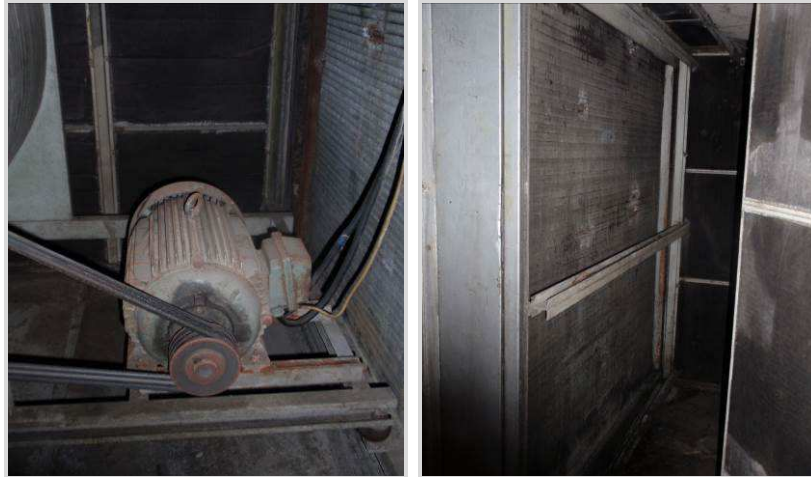
Slika 25: Elektromotor ventilatora i izmjenjivač topline toplozračnog grijanja
