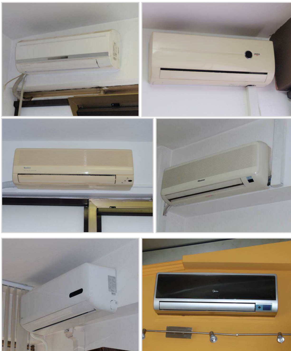
Slika 32: Unutrašnje jedinice rashladnih uređaja split sustava
