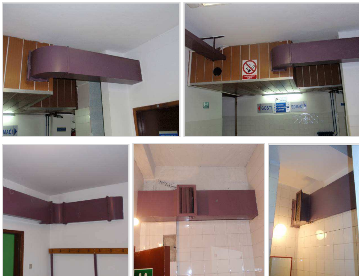
Slika 28: Toplozračno grijanje u podrumu (svlačionice sa tuševima)
