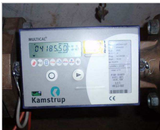
Slika 31: Uređaj za mjerenje potrošnje toplinske energije
