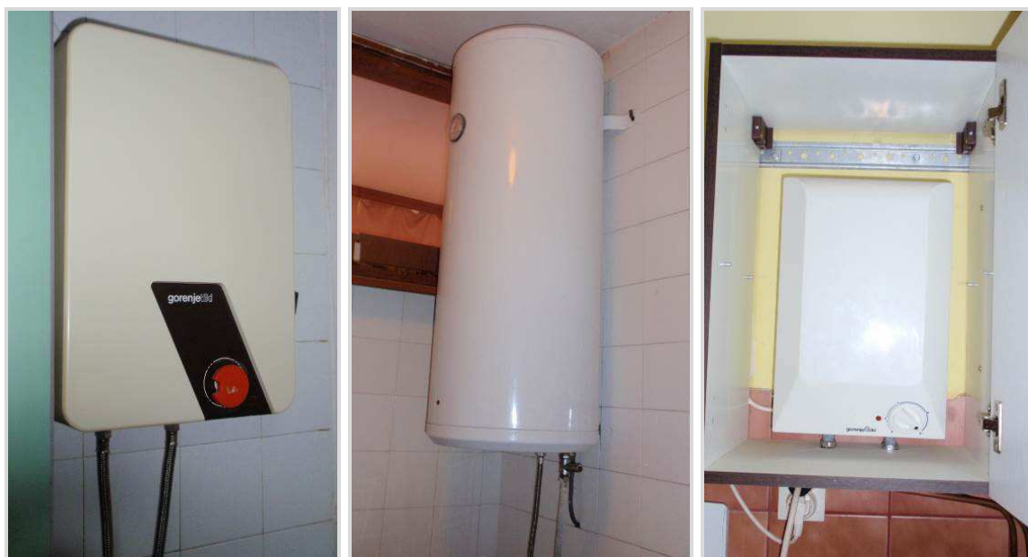
Slika 37: Električne grijalice vode u upravi dvorane
