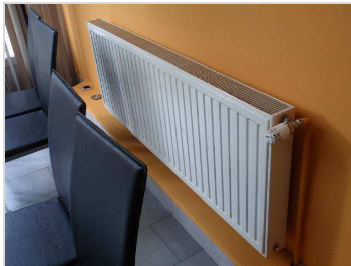
Slika 21: Pločasti radiator u kafiću
