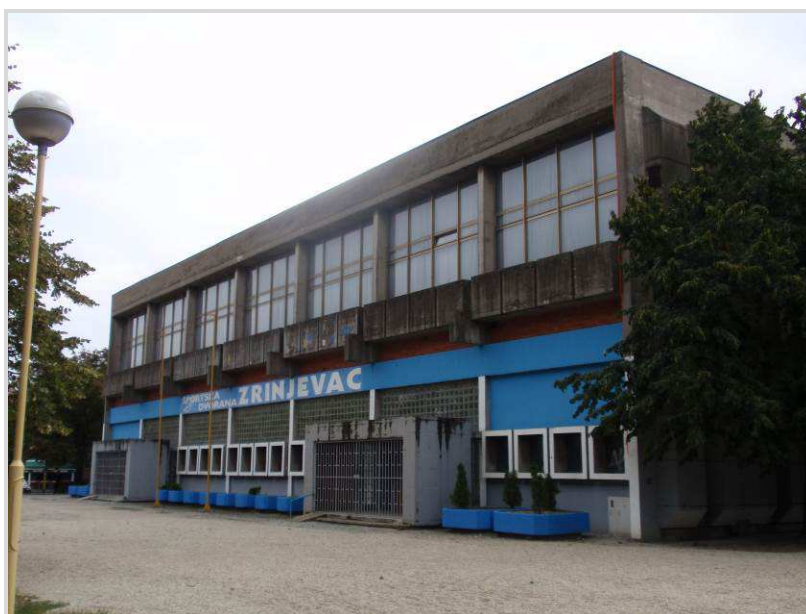
Slika 13: ŠD "Zrinjevac" - ulazi sa sjeverne strane
