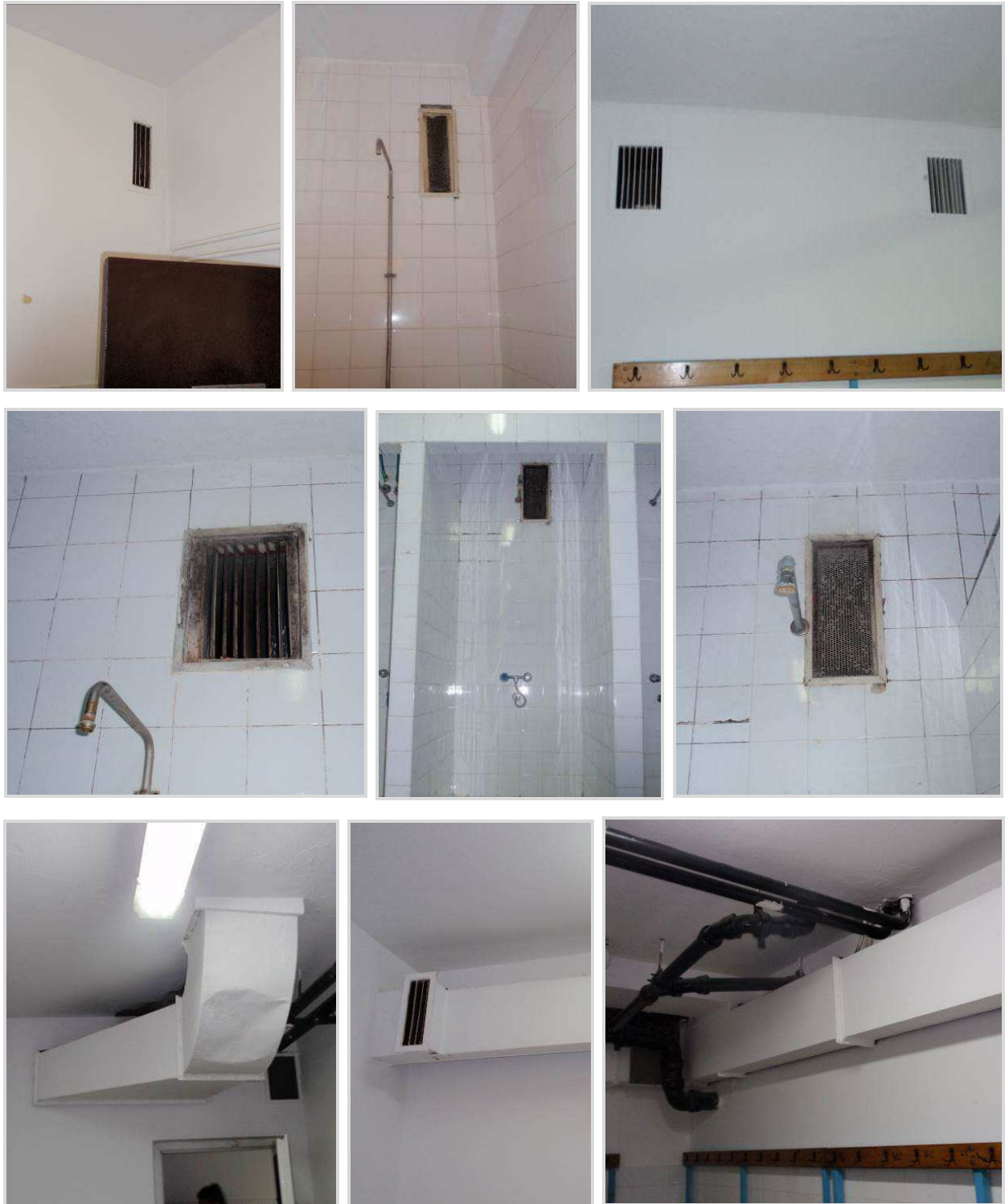
Slika 35: Kanali i rešetke za prozračivanje svlačionica i tuševa
