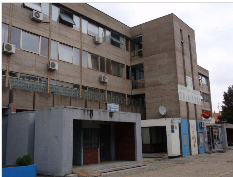
Slika 1: ŠD "Zrinjevac", južna fasada
