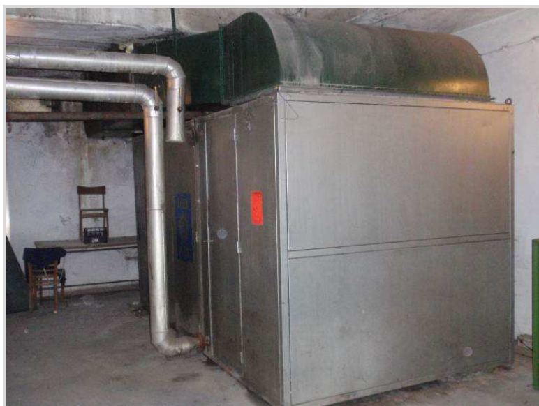
Slika 24: Centralni uređaj za toplozračno grijanje
